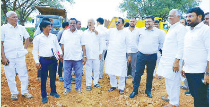
యంగ్ ఇండియా సమీక్ష నిర్మాణ పనులను పరిశీలిస్తున్న ఎంపీ, ఎమ్మెల్యే, ఎమ్మెస్సీ, కలెక్టర్
